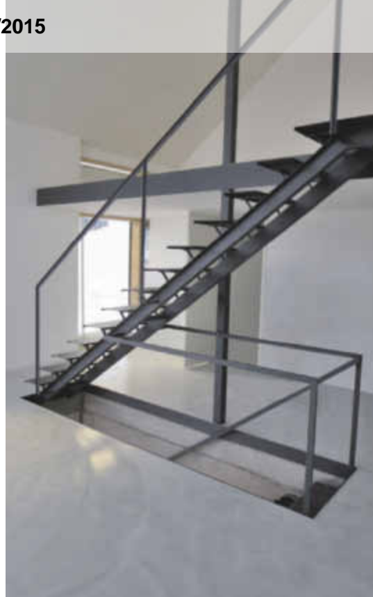
Über die Stahltreppe – mehr Möbelstück als Bauteil – werden vom EG aus das Untergeschoss sowie die darüberliegende Arbeits-Galerie erschlossen.
