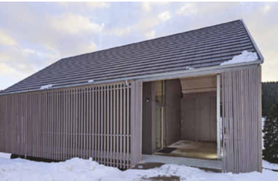
Der „Schiebevorhang“ aus Weißtanne-Stäben lässt sich schließen und vervollständigt so die Hülle.
