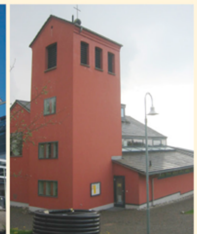
Die Gnadenkirche wird nun allein durch eine 120 m lange Nahwärmeleitung mit Wärme versorgt.
