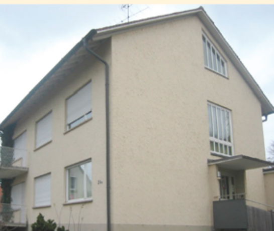
Das Pfarrhaus in unsaniertem Zustand...
