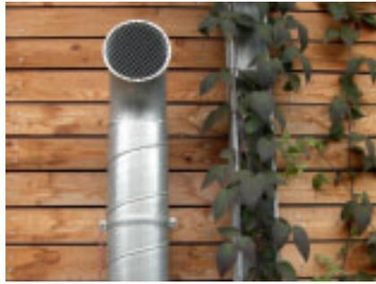
Kontrollierte Lüftung: Beispiel einer gestalteten Luftansaugöffnung im Fassadenbereich
