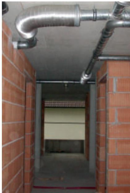
Kontrollierte Lüftung: Rohrleitungen zur Zuluftverteilung mit eingebauten Schalldämpfern (Vermeidung der Geräuschübertragung zwischen den Räumen)
