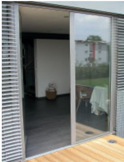
Außen liegender Sonnenschutz aus Aluminium-Lamellenstores
