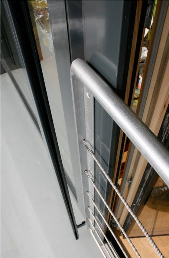
7 Die Holz-Aluminium-Fenster sind mit einer 3-fach-Verglasung mit Argon-Füllung versehen.
