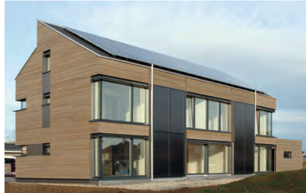
Gute Architektur, angemessene Fensterflächen, nachwachsende Rohstoffe, Passivhauskomponenten und Photovoltaik: Für Plusenergiegebäude auf Passivhausbasis lassen sich die besten Faktoren miteinander kombinieren.
