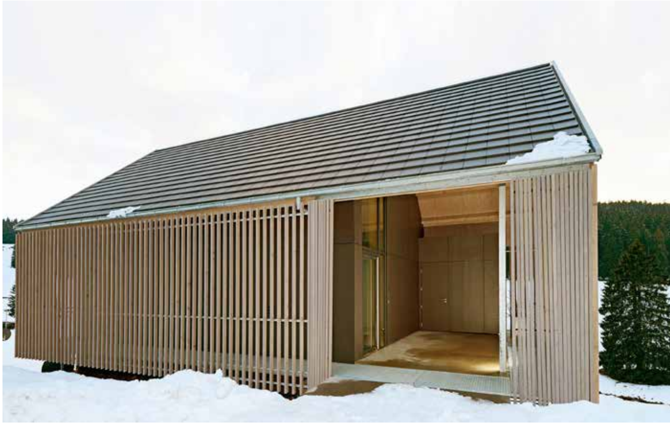
Die Weißtannen-Stäbe sind verschieblich aufgehängt und lassen sich wie ein Vorhang zur Seite fahren.
